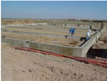
Pour concrete slab.
